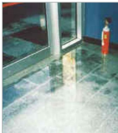
Fig. 2.6 - Esempio di macchiatura su pavimentazione in granito
