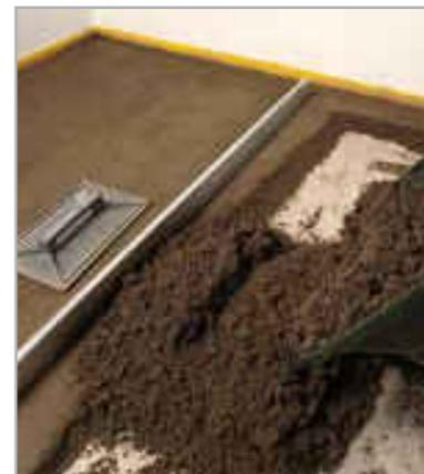
Fig. 3.3 - Realizzazione di massetto in MAPECEM PRONTO
