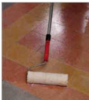
Fig. 3.6 - Applicazione di primer promotore d'adesione
