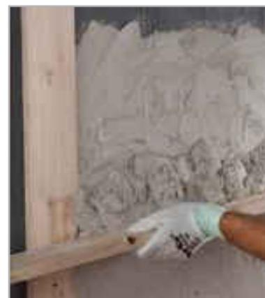
Fig. 3.8 - Regolarizzazione di parete in calcestruzzo con NIVOPLAN+PLANICRETE
