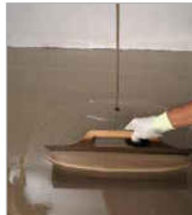
Fig. 5.2 - Lisciatura di massetto cementizio con ULTRAPLAN
