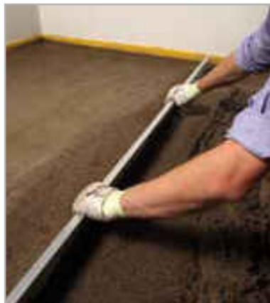
Fig. 3.4 - Staggiatura del massetto
