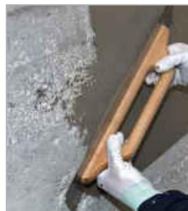
Fig. 3.9 - Regolarizzazione di parete con PLANITOP FAST 330
