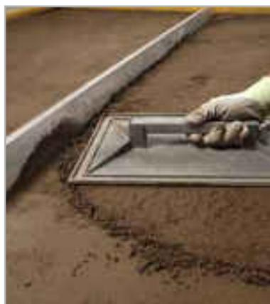
Fig. 3.5 - Frattazzatura della superficie del massetto
