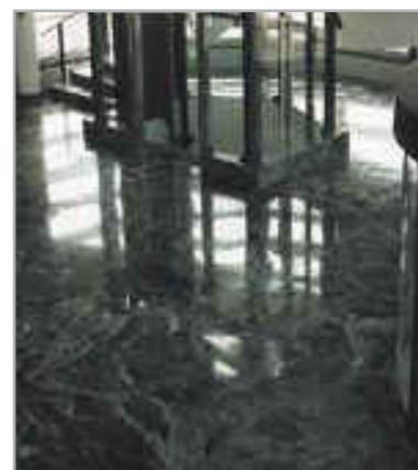
Fig. 4.9 - Esempio di posa di pavimento in marmo Verde Alpi con KERALASTIC - Hall Rolex - Bienne - Svizzera
