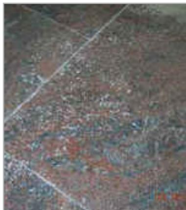
Fig. 2.7 - Esempio di efflorescenze legate a risalita di umidità dal sottofondo
