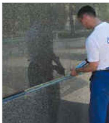
Fig. 4.12 - Sigillatura di giunto di facciata con MAPESIL LM
